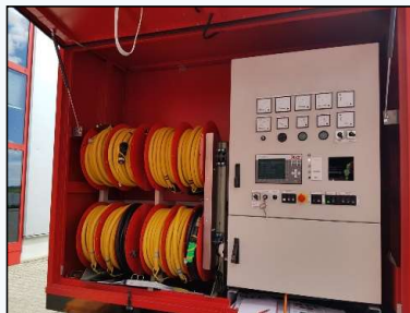
Schaltschrank und Kabeltrommeln
